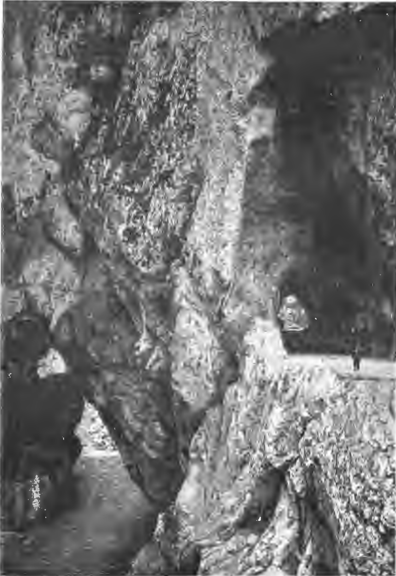
Краснополянское шоссе. Видъ тоннеля и скалы.
